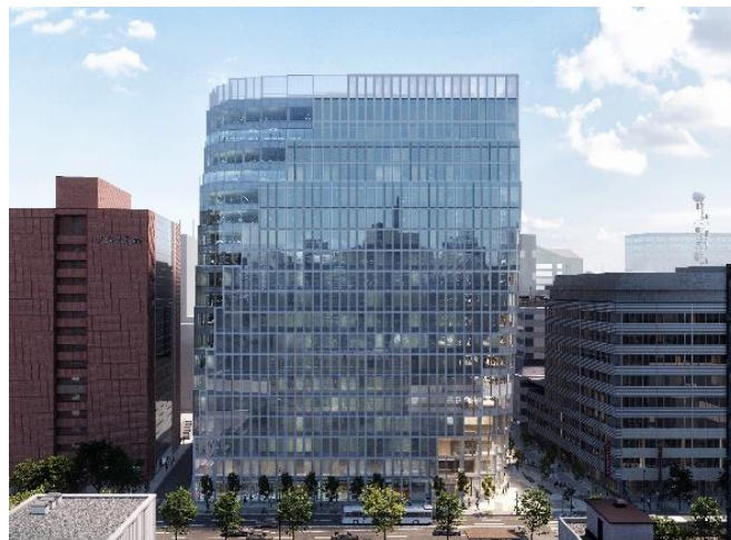
天神ビジネスセンター外観
