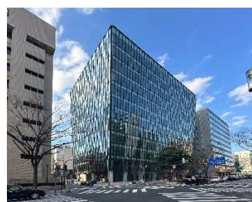
博多 FD ビジネスセンター
